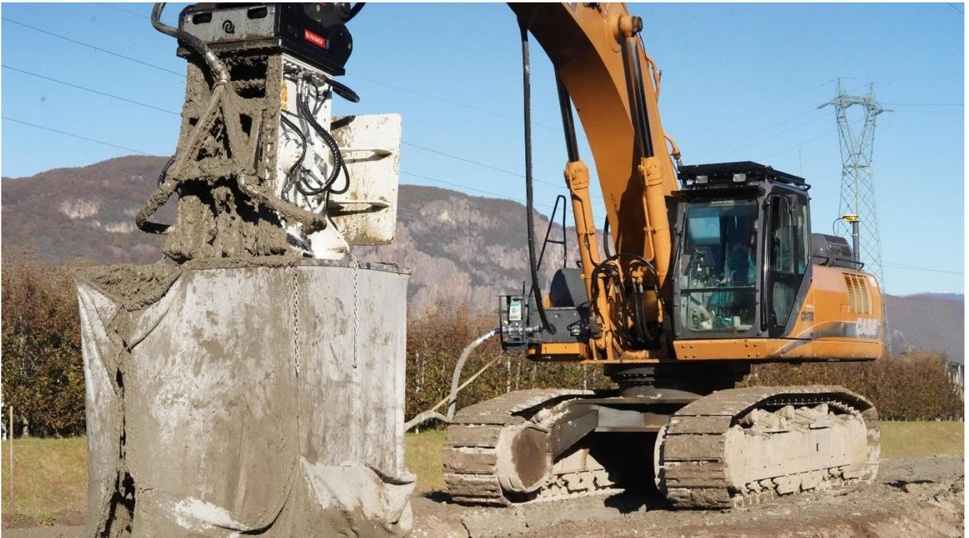
*Figura 9: escavatore con lama miscelatrice in cantiere in posizione di lavoro con eventuale protezione*
