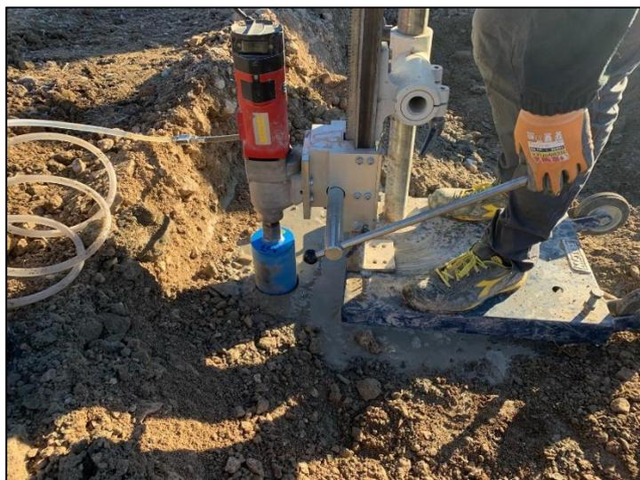
*Fig. 14: carotatrice a colonna durante la fase di perforazione*
