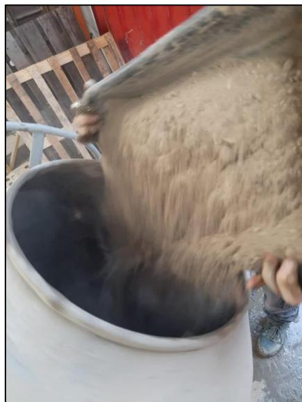
*Fig. 3: Aggiunta del materiale in betoniera*
