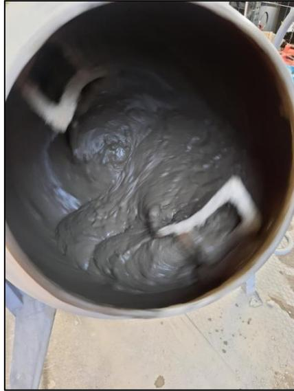
*Fig.4: Aggiunta dell'acqua e miscelazione*
